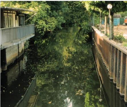
Abb. 20: Spundwände („Knackpunkt“) in Walsrode. Foto: W. Burkart.
